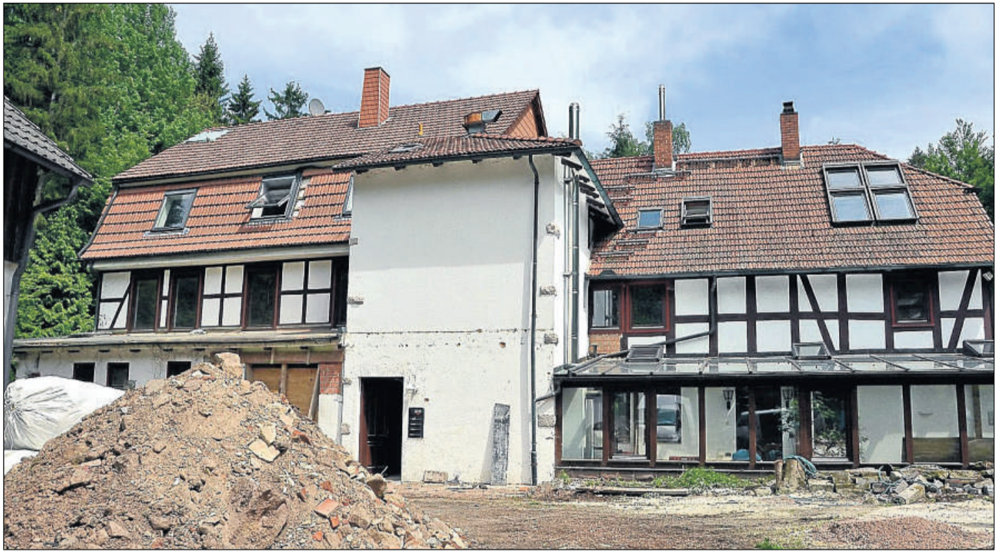
Die Bauarbeiten sind im vollen Gange: Im ehemaligen Gasthaus Grundmühle in Laubach entsteht eine Einrichtung für schwer erziehbare Kinder.
